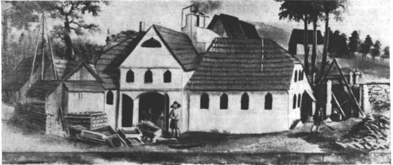
Hammerwerk Erla mit dem alten Hochofen um 1838. Vor dem Gebäude Formkästen und Gußzeugnisse, rechts daneben, vom Wasserrad angetrieben, das Schlackenpochwerk.
